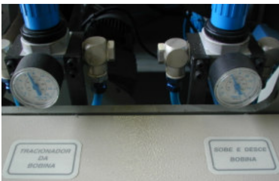
Controle Pneumático do Tracionador da Bobina e Sobe/Desce Bobina.
